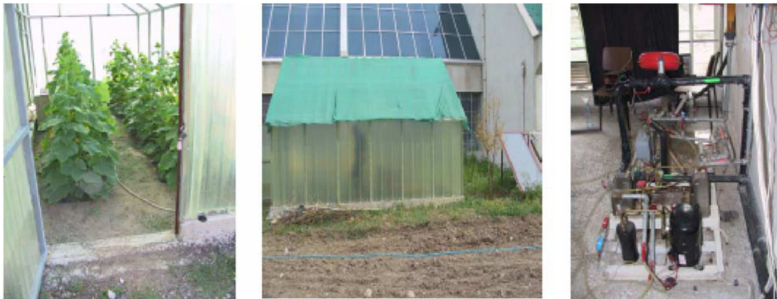
Figura 18. Fotografías del invernadero solar (consistente en fibra de vidrio reforzada con plásticos), las placas solares y el sistema de bomba de calor.
