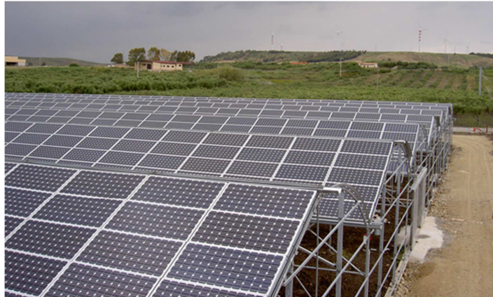
Figura 9. Invernadero multicapilla de techo mixto diseñado con placas fotovoltaicas.
