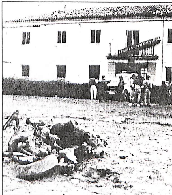
Estado en el que quedó el coche bomba utilizado en el atentado.
