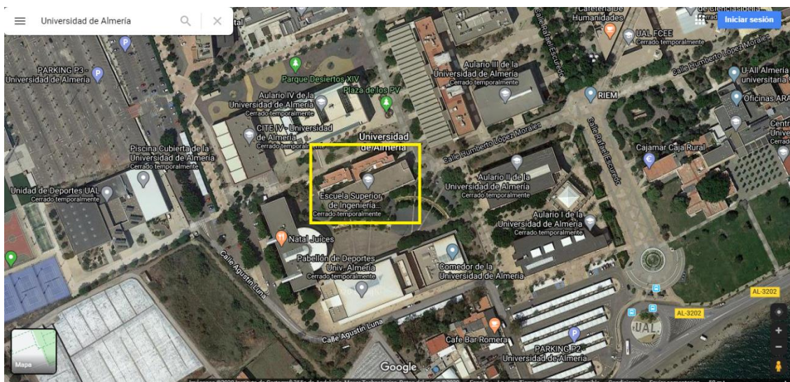
Figura 3: Vista aérea de la Universidad de Almería y localización de la Escuela Superior de Ingeniería. Fuente: https://www.google.com/maps/place/Universidad+de+Almer%C3%ADa/@36.8286624,-2.4065781,314m/data=!3m1!1e3!4m5!3m4!1s0xd7a9c2188f8d897:0x18f22cf3aaf6035b!8m2!3d36.8290435!4d-2.4063528 .
