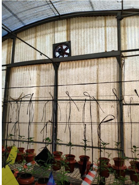
Imagen 5: Sistema de ventilación activo, extractor de aire en la pared norte.
