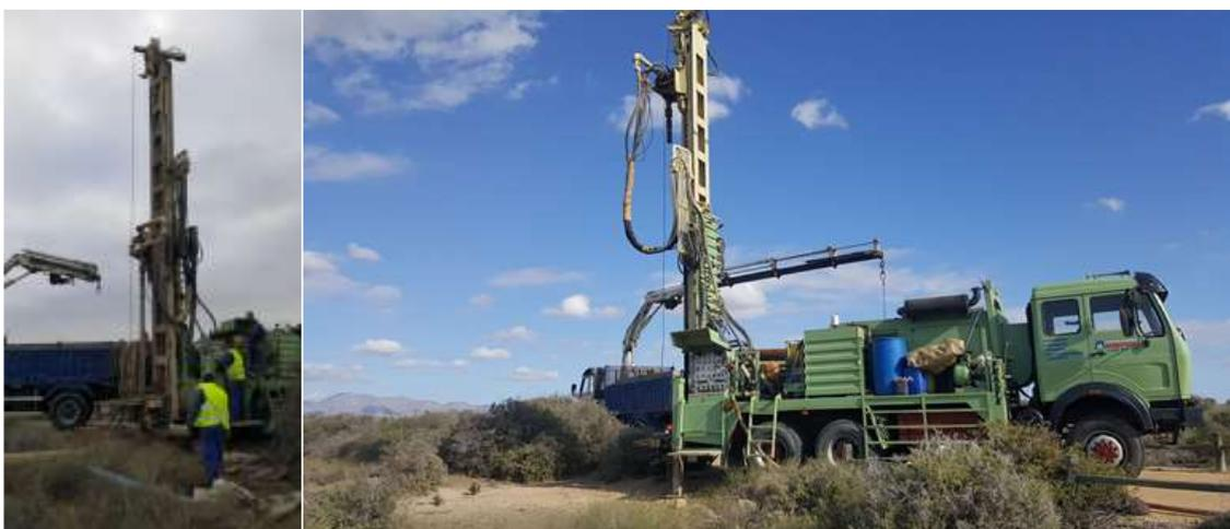
**Figura 6.** Sistema de rotopercusión empleado en la perforación de los pozos. Fuente: CAESCG.
