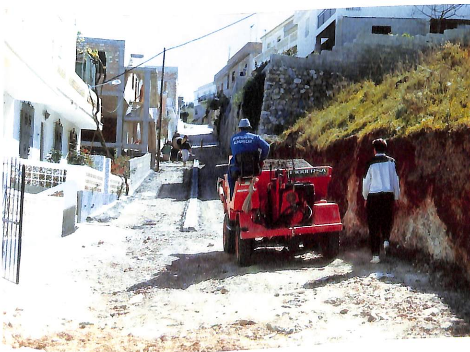
Urbanización Maravillas Norte (en ejecución).
