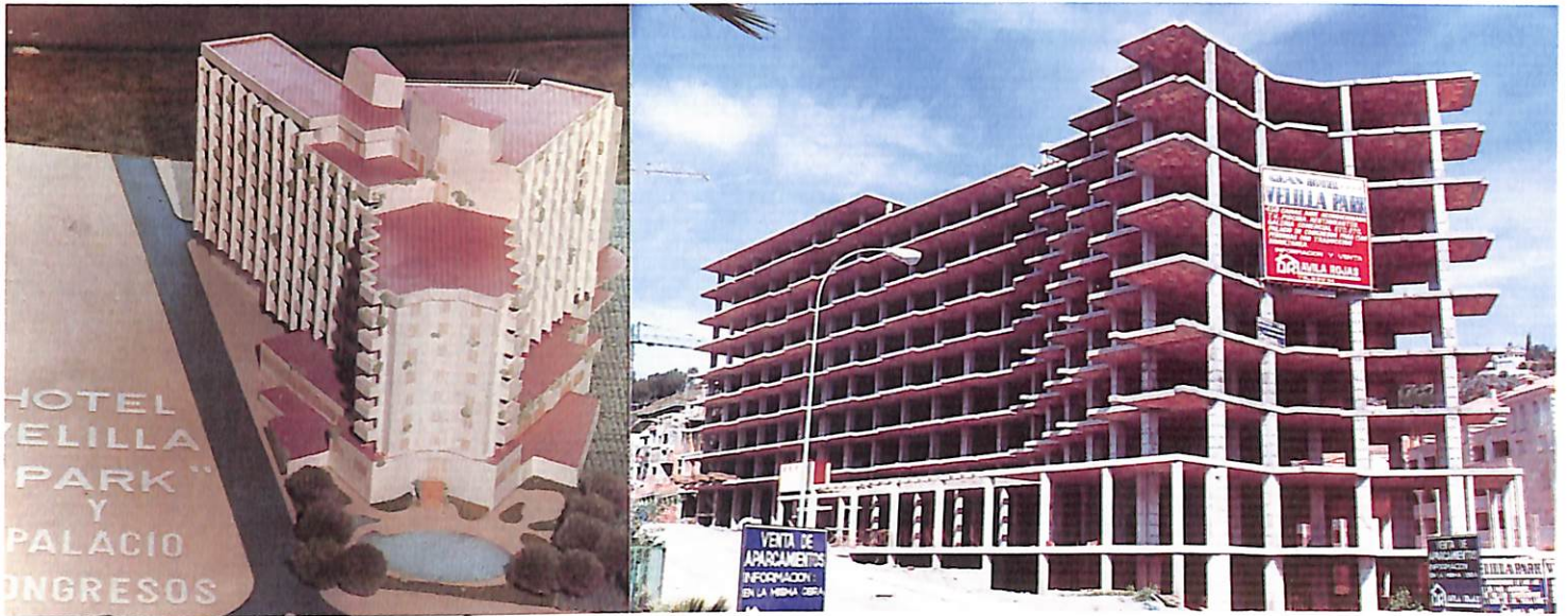
Hotel Velilla Park en obras con su gran centro de Congresos.
