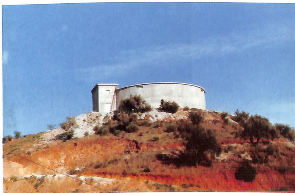
Depósito “El Toro”. Un millón de litros.
