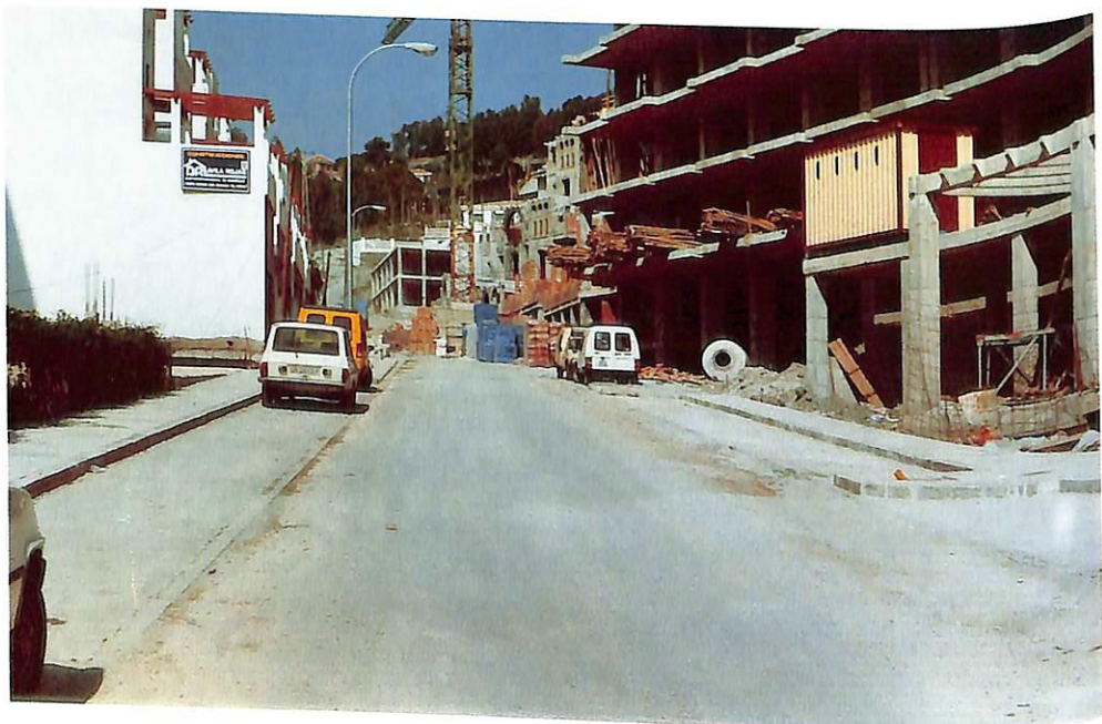
Urbanización Camino Viejo de Velilla (en ejecución).
