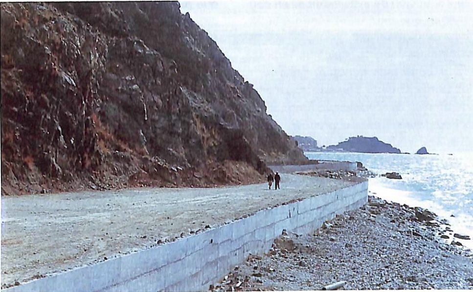
Paseo China Gorda-Cotobro (en construcción).
