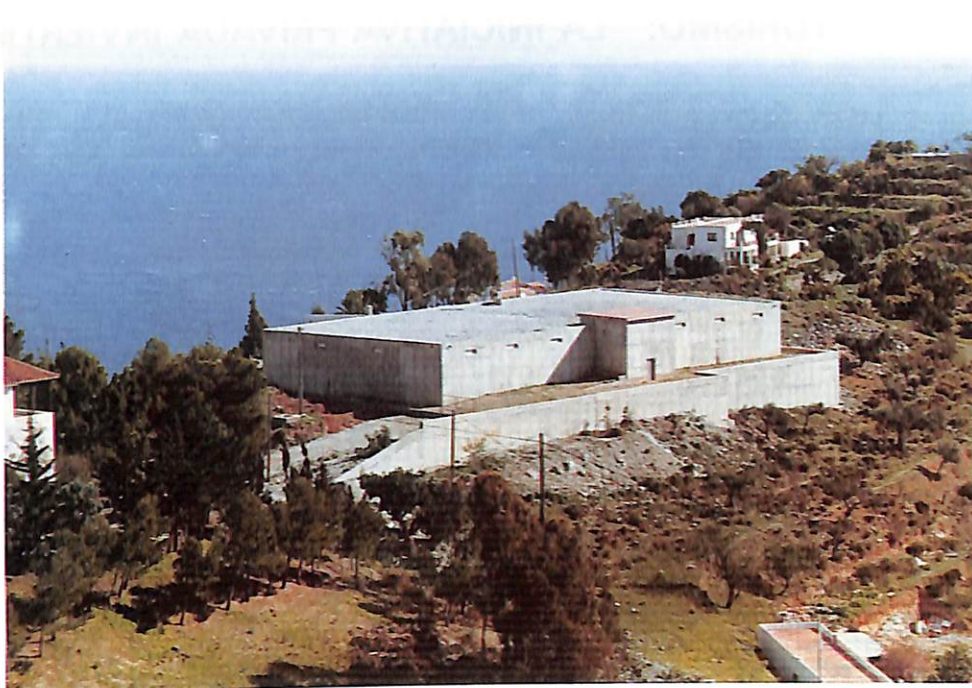
Depósito “El Montañés”. Cuatro millones de litros.
