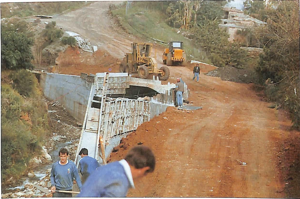
Puente de Río Seco en Cuesta de Cordovilla (en construcción).
