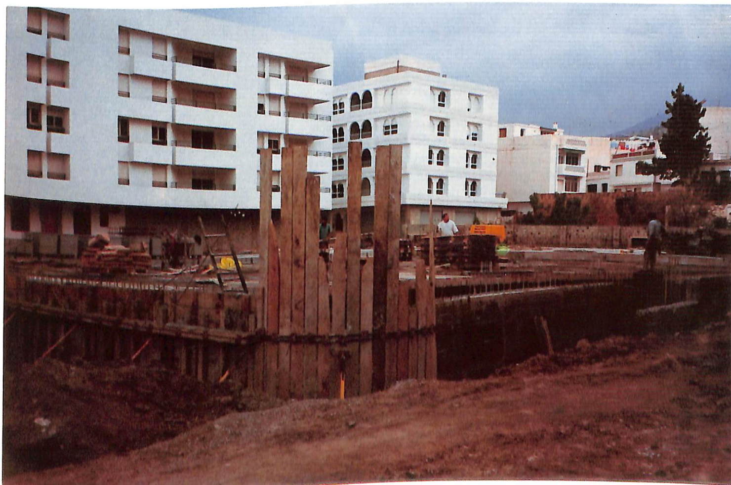
Aparcamiento municipal en La Herradura (en construcción).
