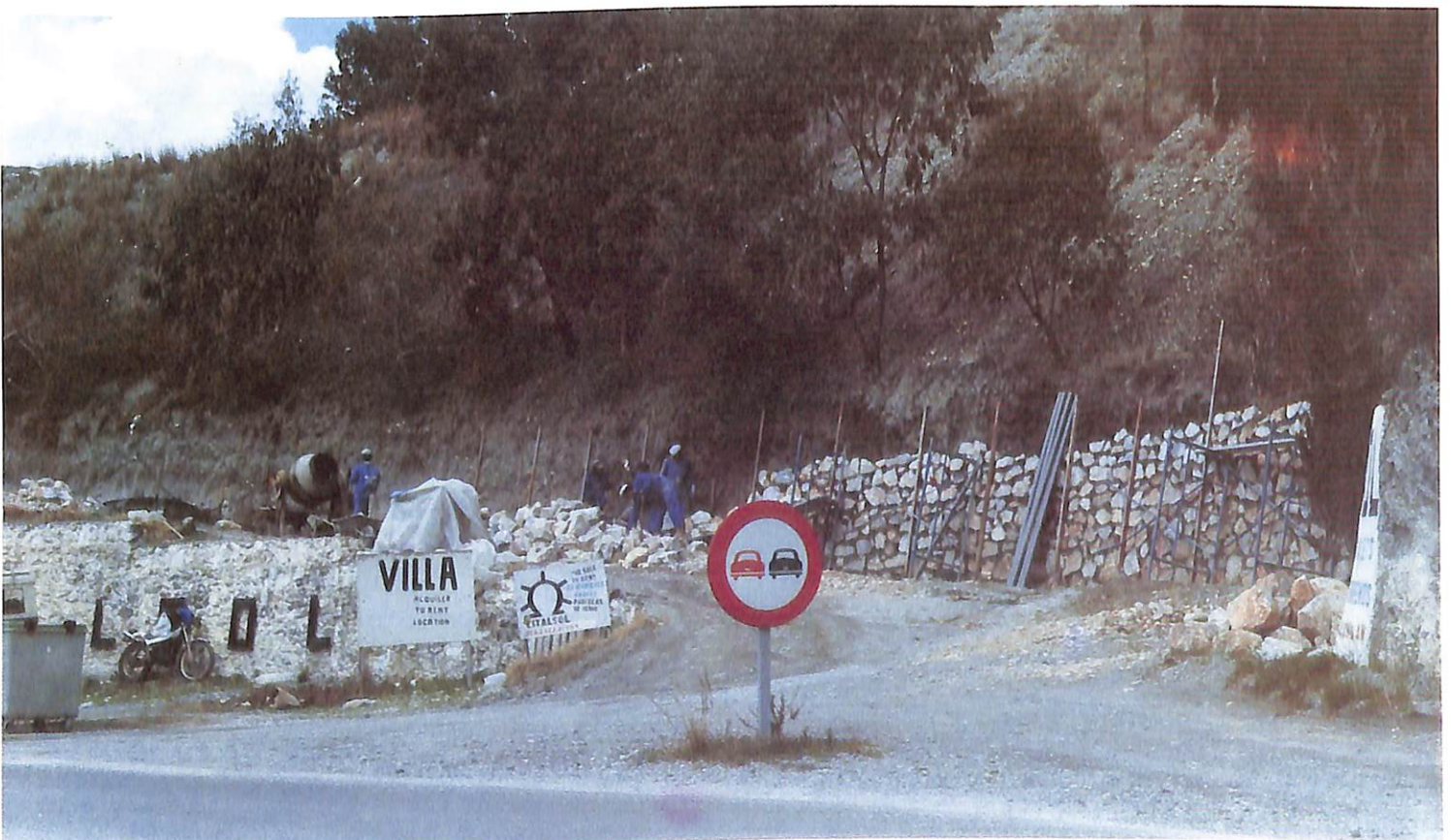
Camino Itrabo-Taramay (en construcción).
