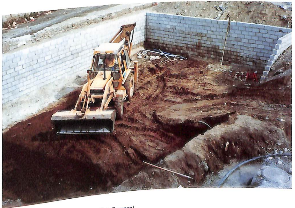
Pista de Skate en construcción (La Carrera).
