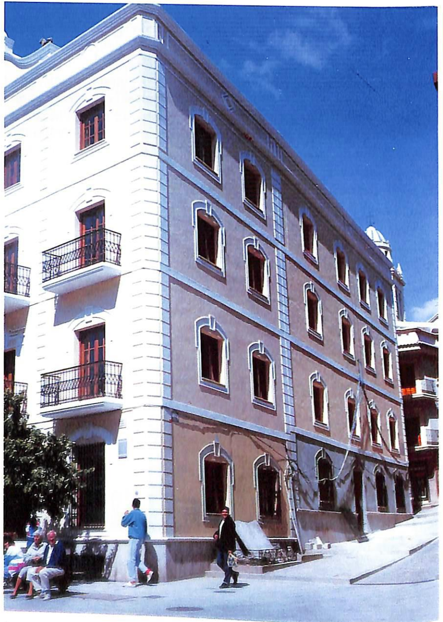
Ampliación de la Casa Consistorial.
