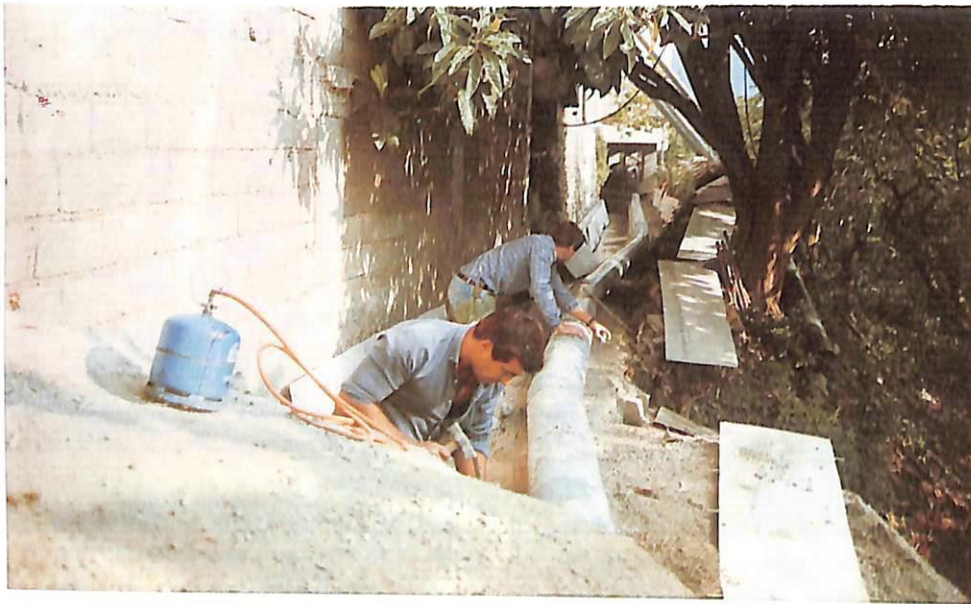
El saneamiento de Torrecuevas va siendo una realidad.
