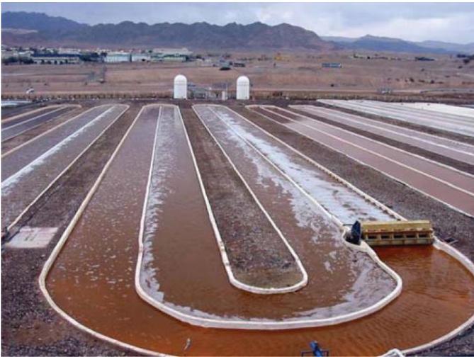
Figura 17. Sistema abierto de tipo *raceway* de producción de biomasa en Eilat, Israel [32]
