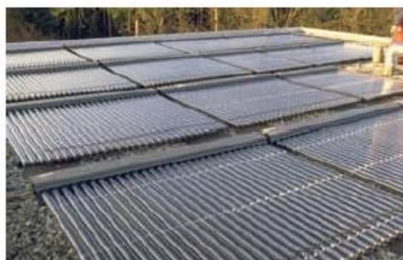
**Figura 13: Tubos de vacío.**
