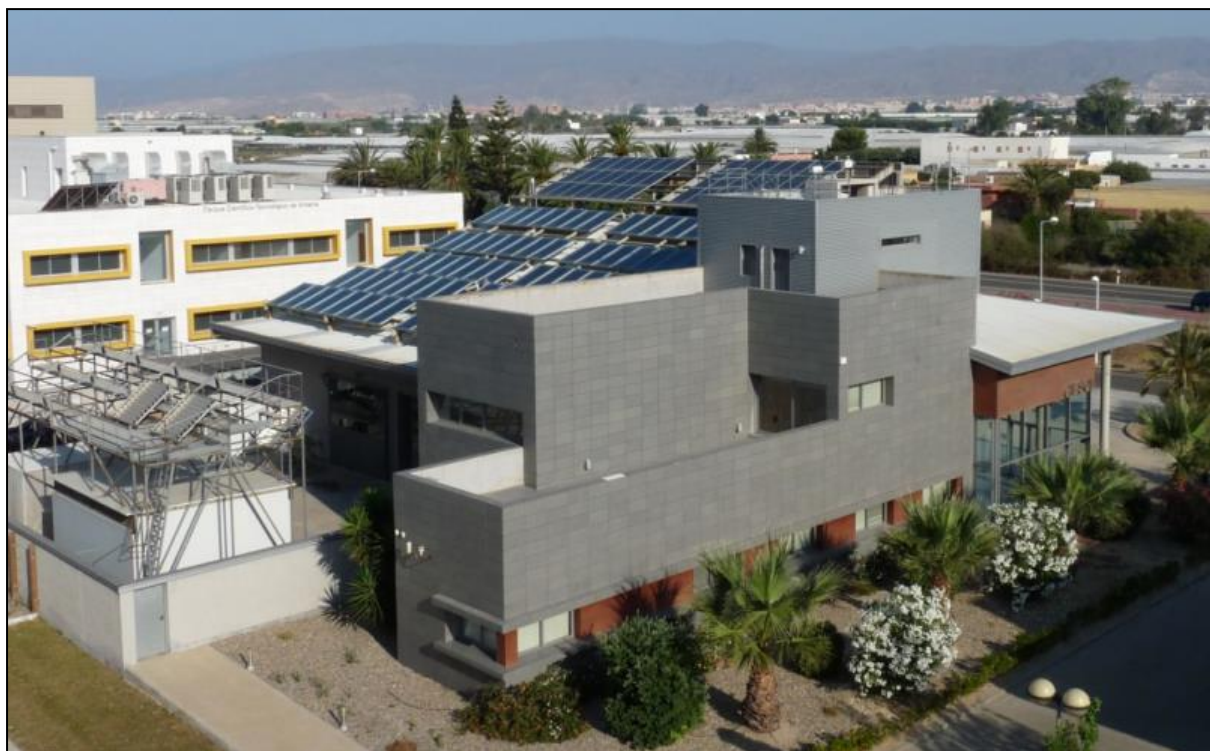
Figura 3.1. Vista exterior del edificio bioclimático CIESOL
