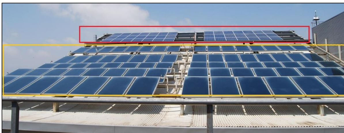
Figura 3.3. Instalación fotovoltaica (rojo) y de captadores solares (naranja) en CIESOL
