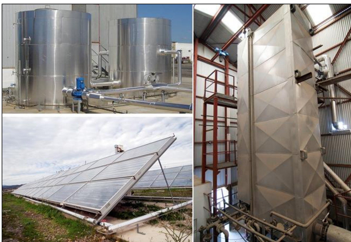
Figura 3.7. Elementos del sistema AQUASOL: tanques de almacenamiento térmico (arriba), campo de captadores solares (abajo) y desaladora MED (derecha). Fuente: [65]
