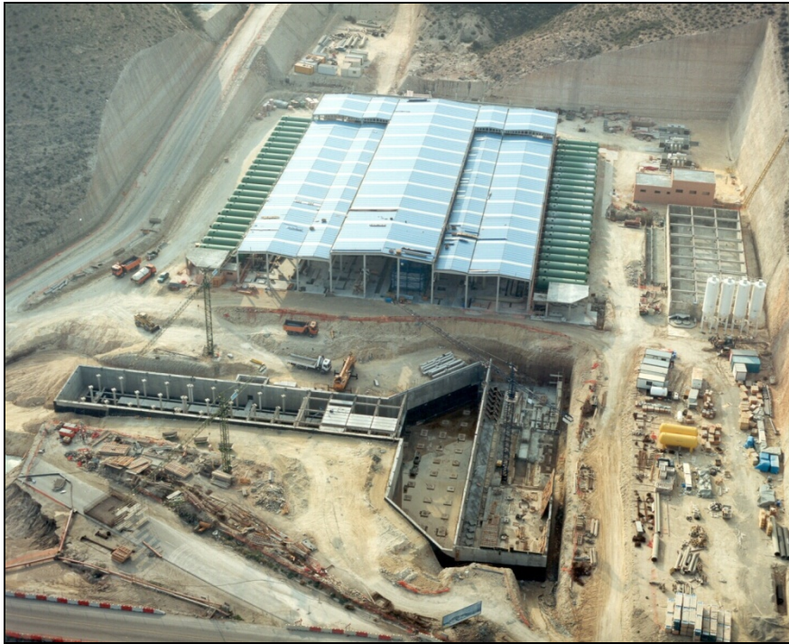
Desaladora de Carboneras en construcción. Foto cortesía de Acuamed.
