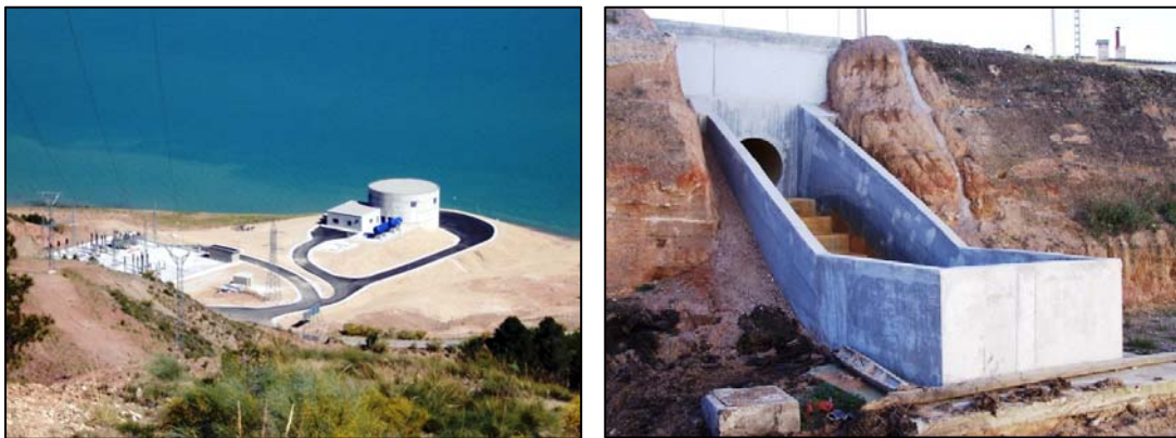
A la izquierda estación de impulsión situada junta al embalse del Negratín. A la derecha final del trasvase del Negratín. Fotos del autor y cortesía de Acuamed (izq.).
