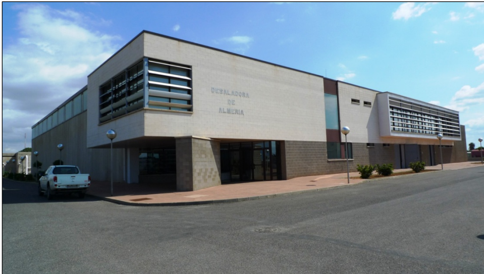
Desaladora de Almería. Foto del autor.
