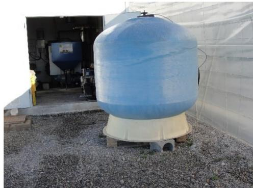
Figura 13. Tanque en el que se ubica el carbón activo.
