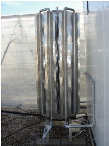
Figura 12. Primer cambiador de calor dispuesto a la salida de la caldera.
