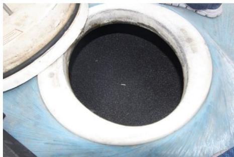
Figura 14. Carbón activo empleado (vista más cercana del lecho tal cual quedo dispuesto dentro del tanque).
