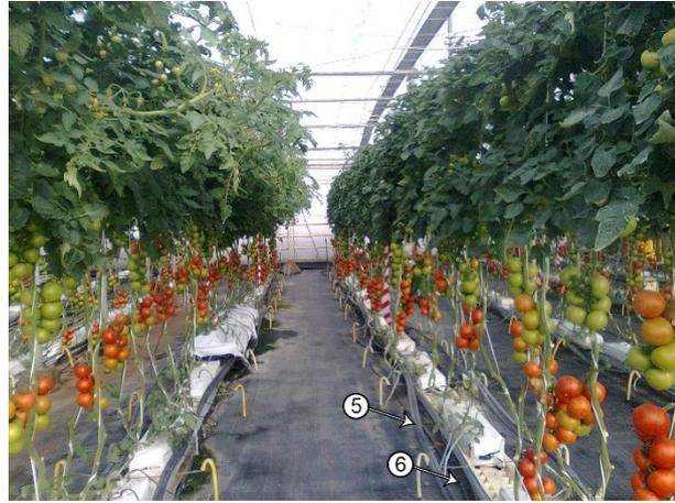
Figura 7. Imagen de las conducciones tanto de (5) los lazos del circuito de agua caliente, como de (6) aquellas dispuestas para distribuir el CO<sub>2</sub> de forma homogénea por todo el invernadero.
