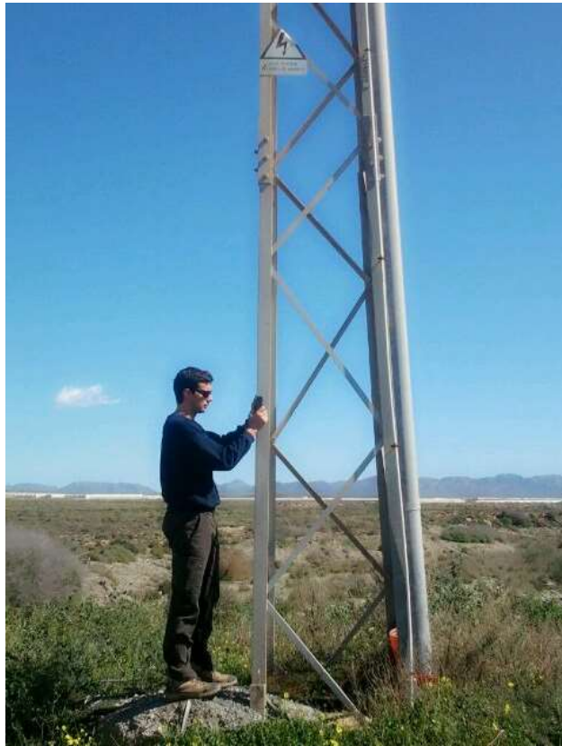
Figura 3. 12. Medición con láser de la altura de un poste eléctrico.
