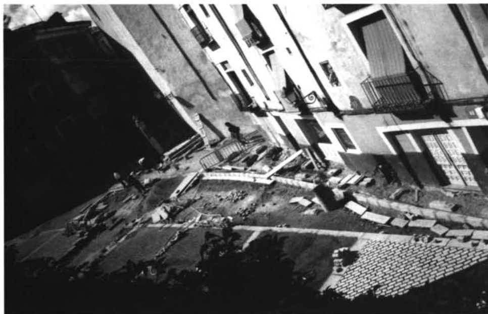
Fig. 5. Renovación del alcantarillado, luz, conducción de aguas y pavimentación.
