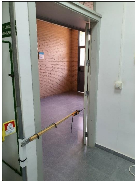
Figura 31. Disposición del sensor Testo 440dP para medida de velocidad del aire en la puerta en la pared este durante el primer ensayo experimental.
