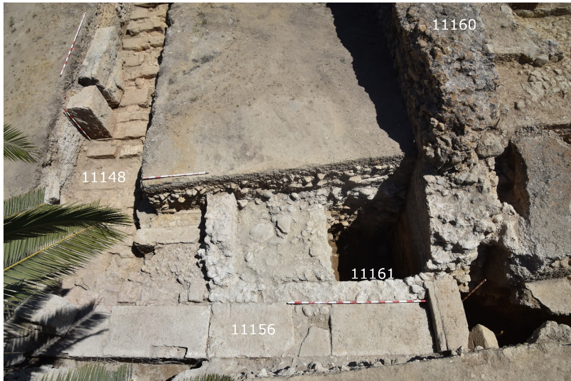
Figura 14. Corte 11, sector F: muro perimetral Norte 11156 del segundo templo fenicio-púnico. Al Sur se adosan los muros 1160 y 1161 de la cisterna romana construida sobre el templo.
