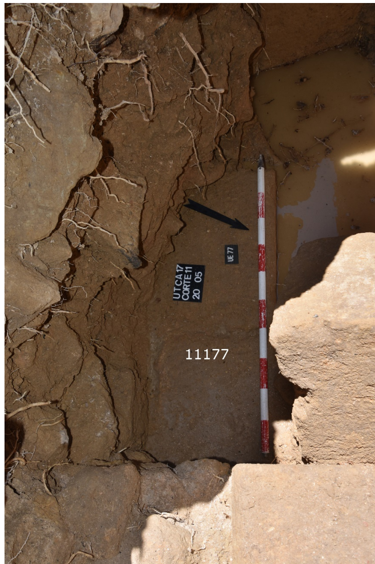
Figura 16. Corte 11, sector F: ángulo Noroeste del templo con el muro perimetral Este de sillares 11176.
