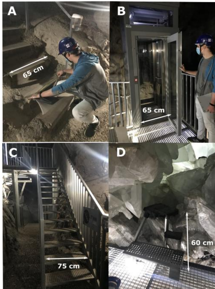
Figura 31. A. Mediciones de la escalera de acceso a la Sala de la Luminiscencia; B. Montacargas que da acceso al nivel inferior; C. Escalera de acceso a la Geoda Partida; D. Escalera para acceder a la Geoda Gigante.
