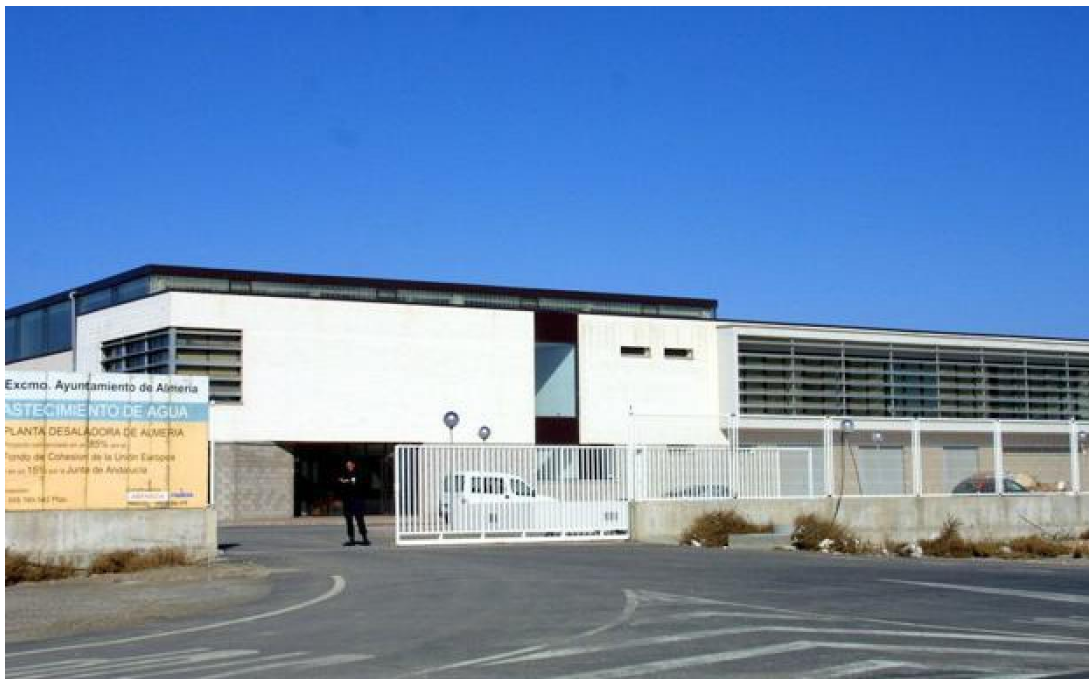
Figura 24. Acceso a la desaladora del Bajo Andarax.
