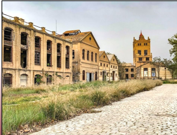
Ilustración 10. Azucarera de San Isidro (Granada). Fuente: Azucarera de Granada [En línea]. Recuperado el 8 de junio de 2022, de https://www.azucarera.degranada.com/
