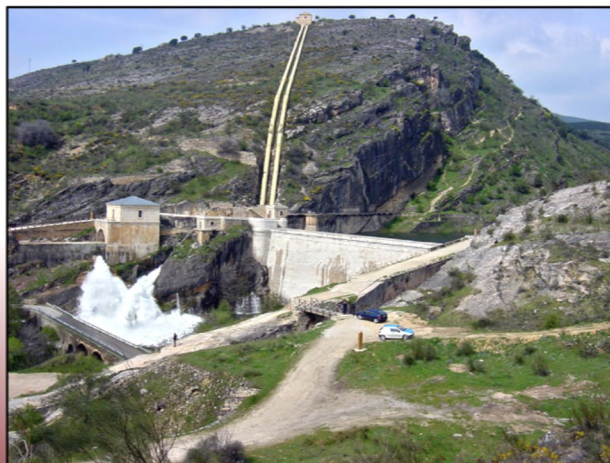
Ilustración 9. Complejo hidráulico del Canal de Isabel II (Madrid). Fuente: Wikipedia [En línea]. Recuperado el 8 de junio de 2022, de
