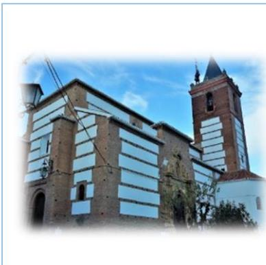
El exterior del templo muestra la fábrica de sus muros, en blanco los cajones de mampostería (piedras irregulares unidas con algún tipo de mortero y después enlucidos) encintados con hileras de ladrillo y fuertes machones en los ángulos y portadas para darle mayor solidez
