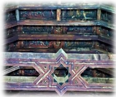
En esta imagen se observa uno de los extremos de la armadura de par y nudillo de la nave central, con las tirantes pareadas decoradas con lacería y estrellas de ocho puntas nazaríes o granadinas, en los ángulos la función de tirar de los muros la ejercen los cuadrales.
