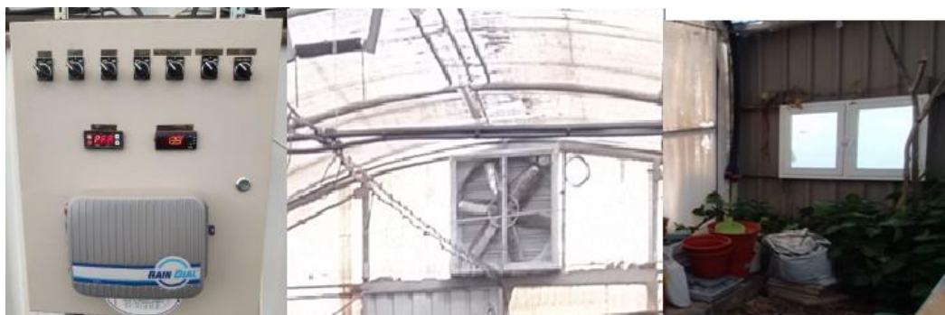
Ilustración 7. Controlador (izquierda), extractor (centro) y ventana lateral (derecha).
