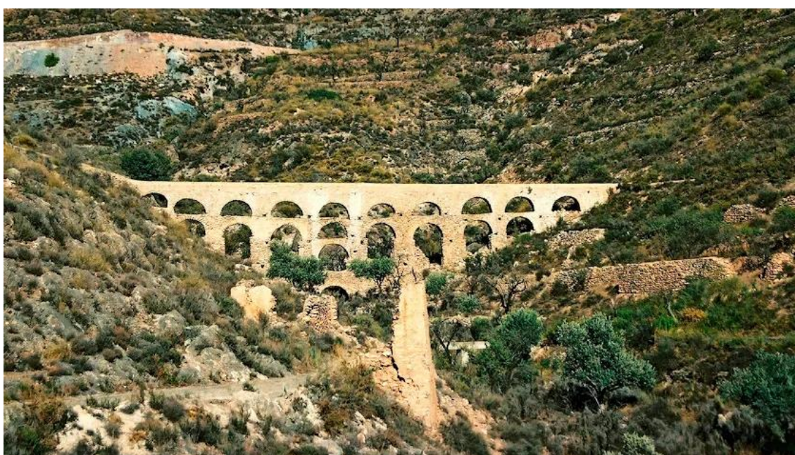
Figura 8. Acueducto de los Veinte Ojos. Fuente: García (2022)
