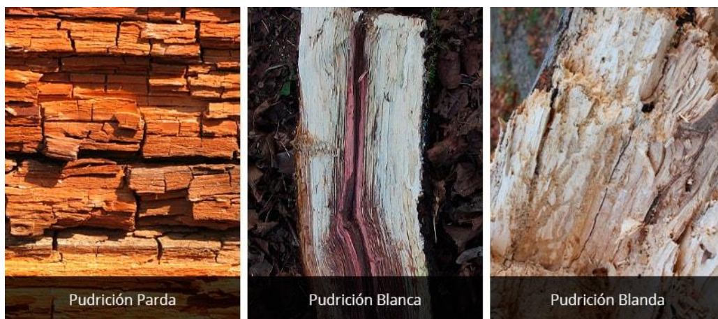
Foto 3: Hongos de pudrición de la madera. Fuente: Anónimo (2020).
