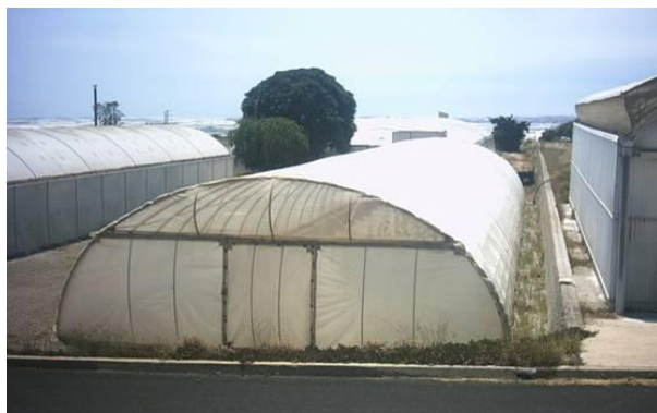
Foto 9: Vista exterior invernadero túnel
