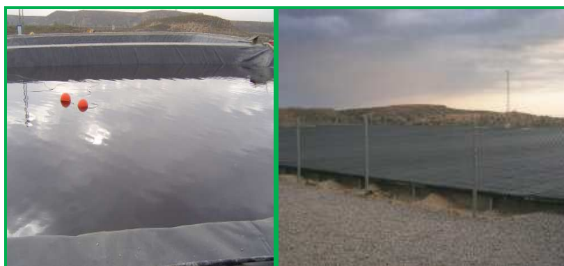
Figura 45. Detalle de las balsas. Figura 46. Detalle de las balsas techadas.
