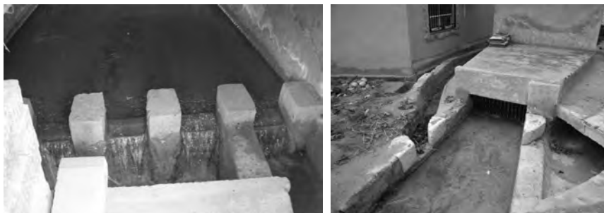
Figura 3. Izq. Interior de la Casilla de Los Ojos. Partidor del Heredamiento de Aguas. Figura 3. Drcha. Previo a la entrada del agua a la Casilla de los Ojos, se observa los marcos para la distribución de las aguas de avenida, margen izquierda una quinta parte para Sahués y margen derecha cuatro quintas partes para la Huerta de Abajo.
