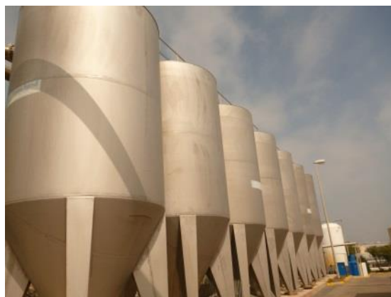
Foto 2: Vista lateral de los filtros de arena Dynasand Fuente: Propia
