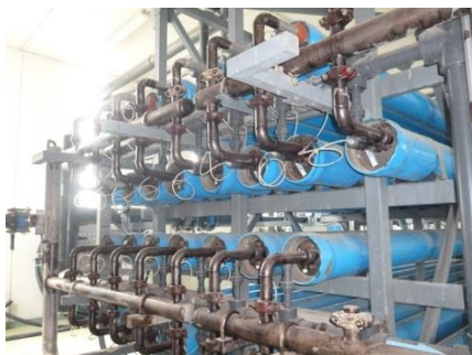
Foto 10 bastidores de la Osmosis Inversa
