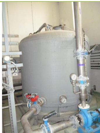
Foto 7 Deposito del Sistema CIP Fuente: Propia
