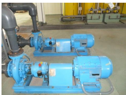
Foto 8 Bomba del filtro de cartucho
