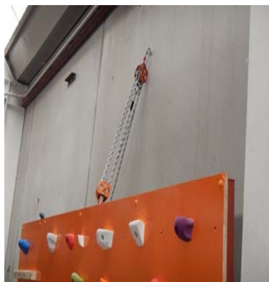
Figura 7. Detalle del sistema de poleas.
