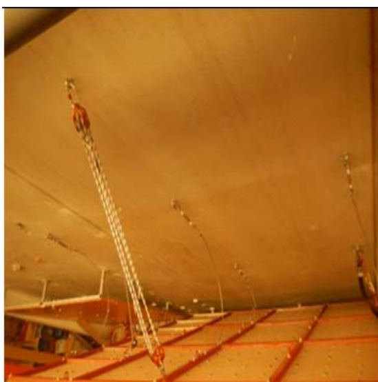
Figura 6. Detalle colocación de parabolt y anillas de sujeción.
