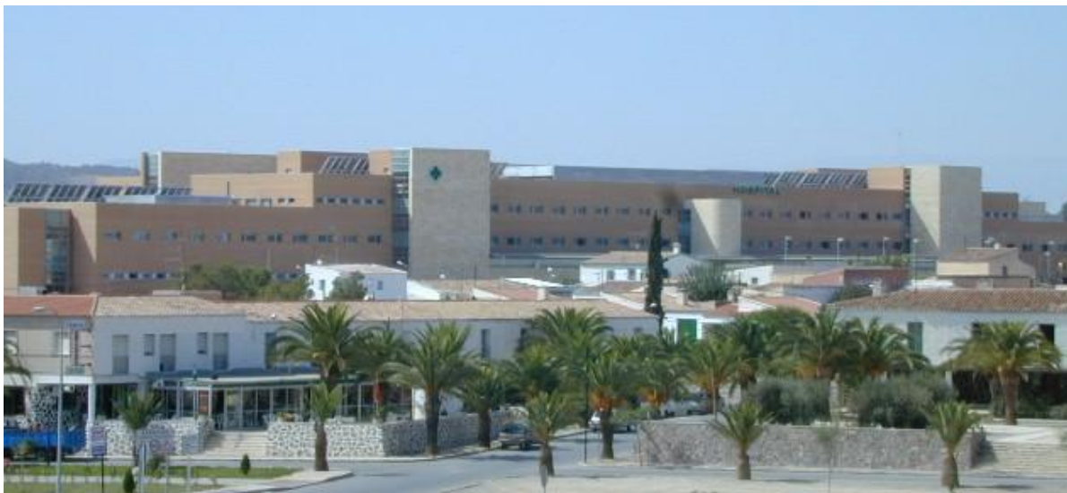
Figura 1.- Vista general del Hospital Comarcal de Huércal-Overa.
