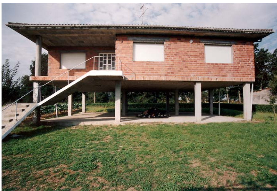
Figura 11. La dimensión técnica de la casa está ideada para permitir la máxima industrialización y el empleo del menor número posible de materiales diferentes.
