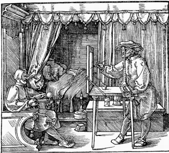
Fig.-8: Alberto Durero, Instrumento perspectivo: mirilla y panel de vidrio. (De " Underweysung der Messung ", Nuremberg, 1525).
