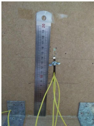
Figura 4.13. Instalación de regleta en el circuito emisor-receptor
