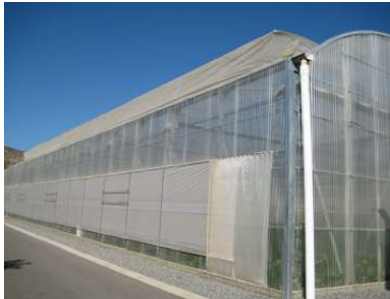
Figura 12. Detalle de la ventilación lateral y cenital del invernadero U9. EP
