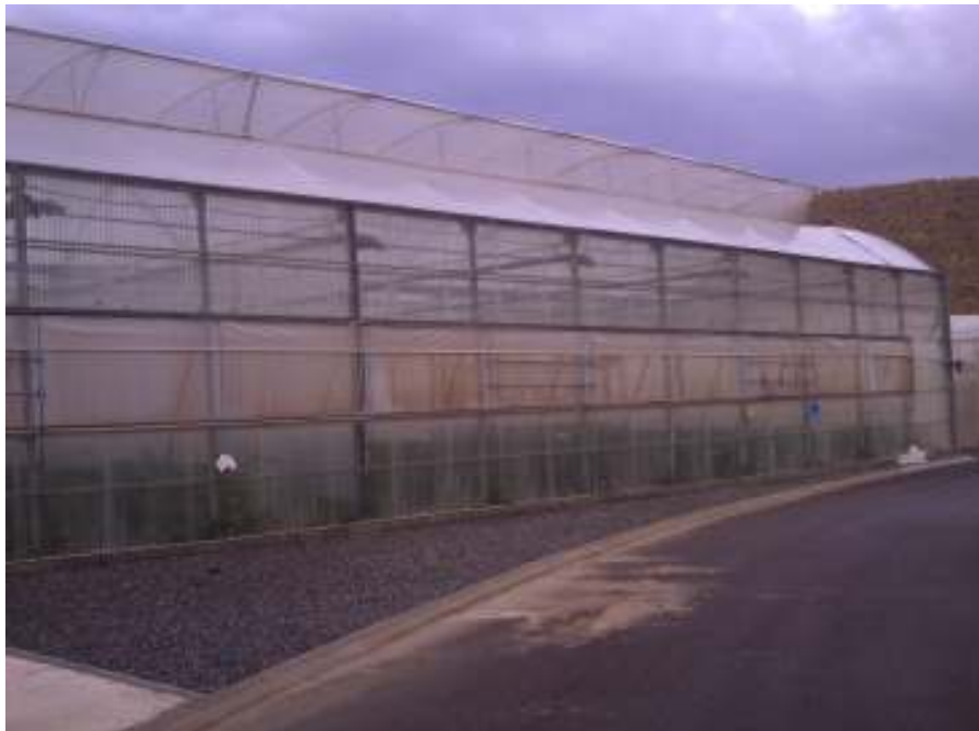
Figura 33. Detalle de la colocación de trampas cromatrópicas en las aberturas de ventilación del exterior de los invernaderos. EP
