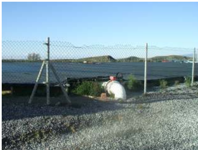
Figura 14. Detalle de las balsas en las que se almacena el agua de riego. EP
