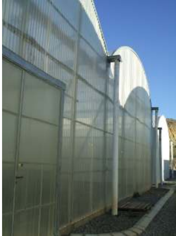
Figura 11. Detalle de las canaletas de recogida de aguas de lluvia. EP
