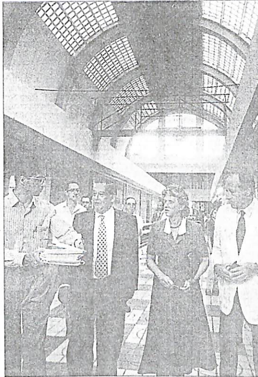
Soledad Becerril visitó ayer las obras del mercado del Arenal.
