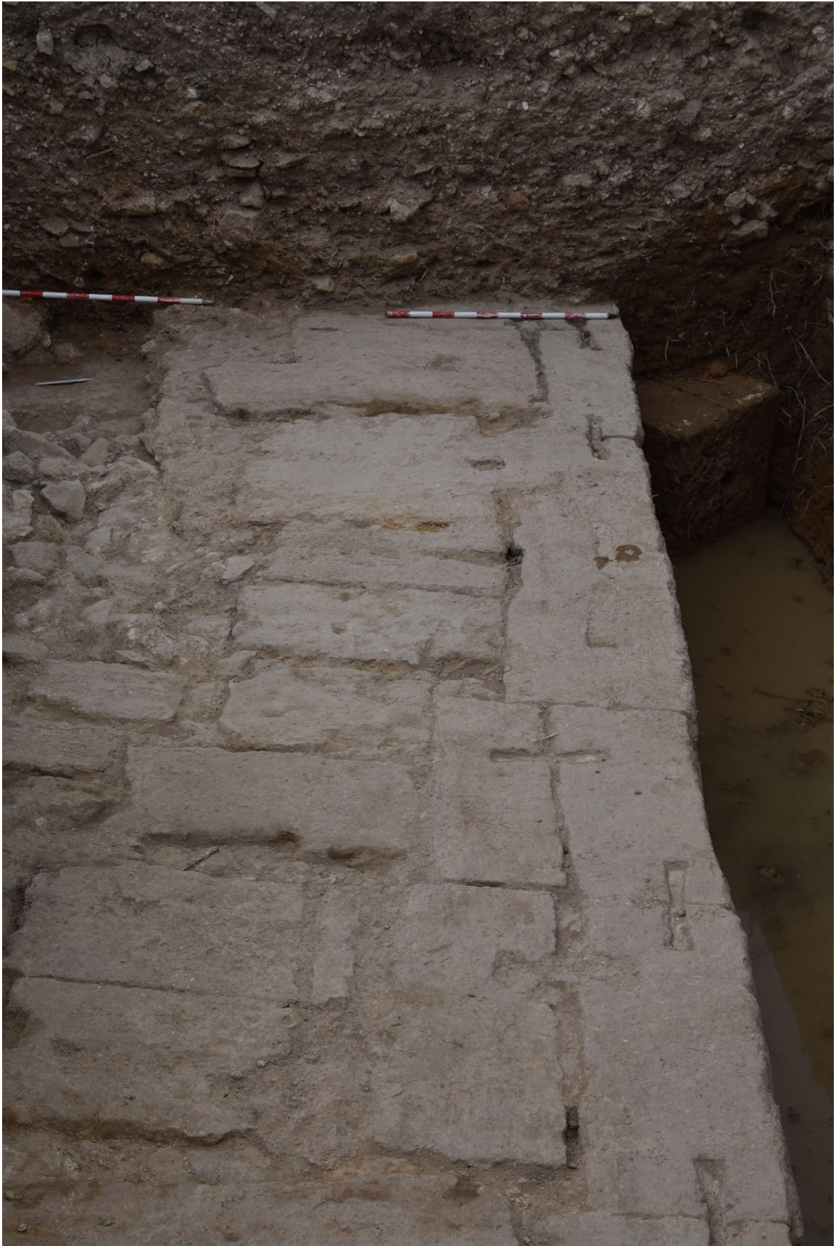
Fig. 16. Detalle de las espigas en cola de milano rellenas de plomo del MR 21123
