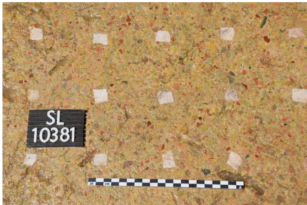
Figura 27. Detalle del pavimento SL 10381
