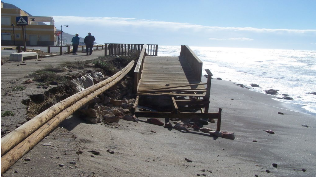
La Almadraba de Monteleva (Almería), tras los daños producidos por un temporal en 2015. Fuente: https://www.miteco.gob.es
