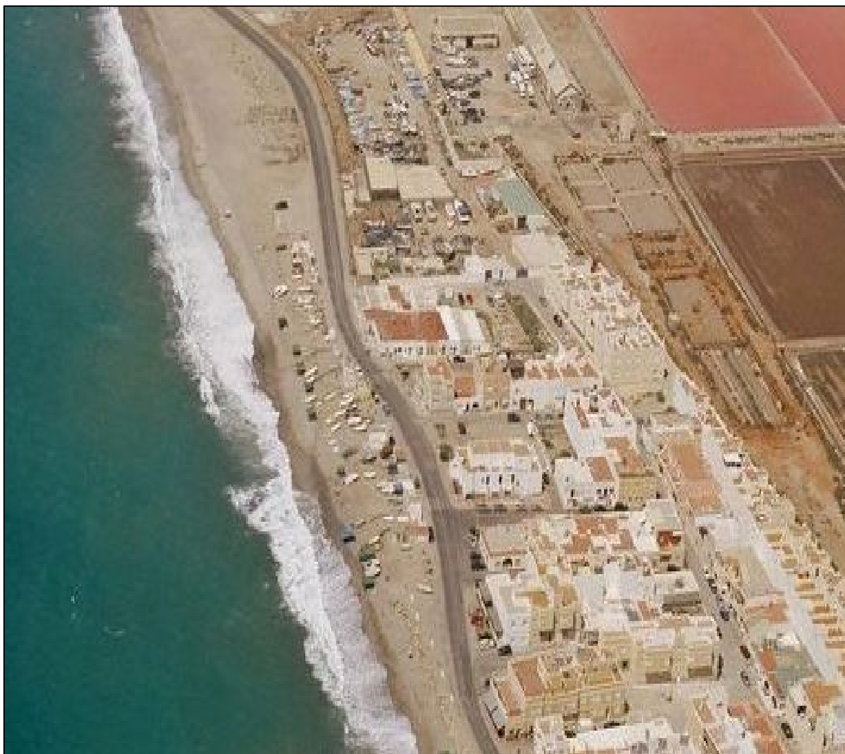
Casetas de aperos de pesca en DPMT antes de la recuperación posesoria. Fuente: https://sig.m-pama.gob.es
