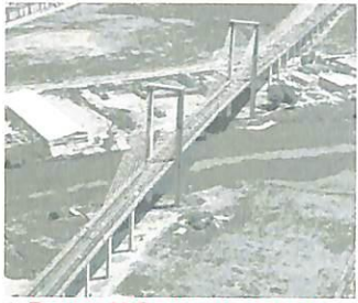
1. Puente V Centenario (1992) Viaducto de 2.000 metros y tablero a 45 metros sobre el río.
