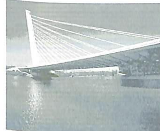
40. Puente del Alamillo (1992) Autor: Santiago Calatrava Valls. Puente atirantado con mástil de 140 m. e inclinación de 58°
