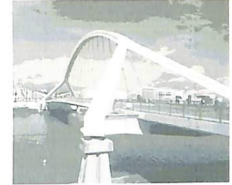
36. Puente de la Barqueta (1991) Autores: Juan José Arenas y Marcos J. Pantaleón. Puente de arco superior atirantado construido en acero.
