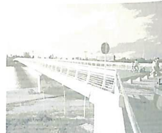
33. Pasarela de la Cartuja (1991) Autores: Fritz Leonhardt y Luis Viñuela. Puente de 238 m. de longitud sin apoyo intermedio.
