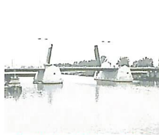
2. Puente de las Delicias (1992) Construido con 2 tableros independientes y levadizo para vehículos y ferrocarril.
