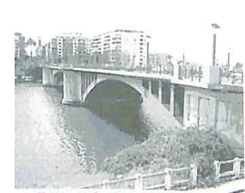
18. Puente de San Telmo (1931) Fue levadizo en su parte central desde 1931 hasta 1963.
