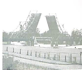
3. Puente de Alfonso XIII (1926) Puente abatible inutilizado desde 1992.
