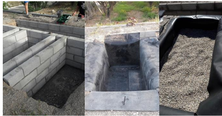
Imagen 9. Construcción fosos SLA asociado a SC
