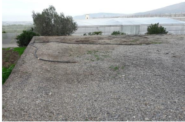
Imagen 8. Construcción SLA asociado a SC: antes.
