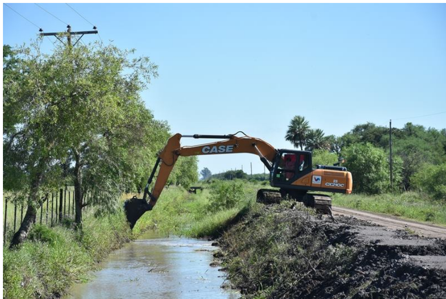
Figura 1.1: Retroexcavadora limpiando un canal
