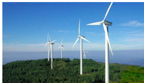
Figura 3. Parque Eólico de Serra do Burgo (Orense, España). Fuente: Iberdrola.
