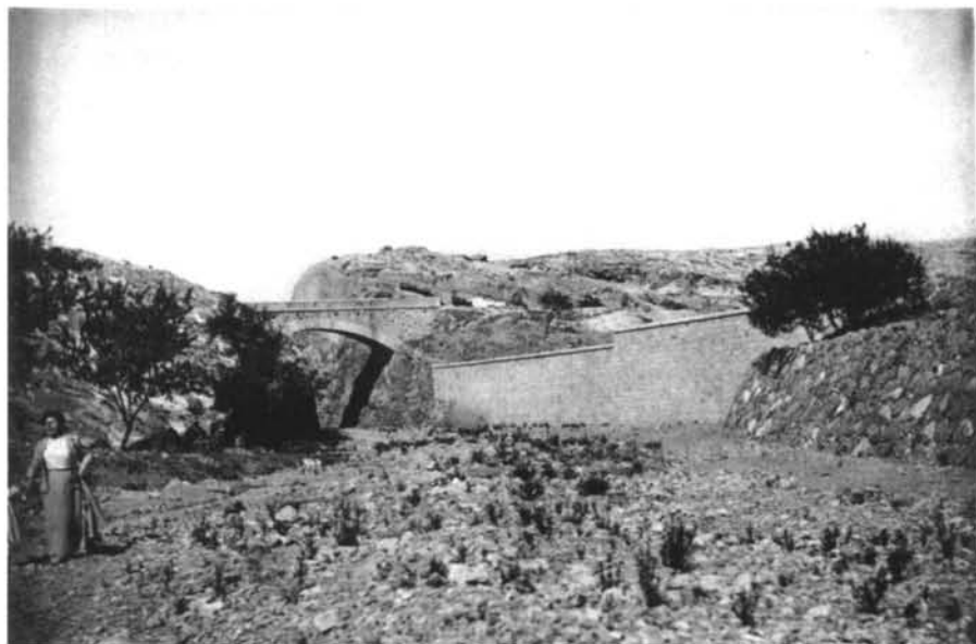
Foto 14. Dique de desviación de la rambla de Alfareros (Memoria "Consuegra-Almería. 1905. Archivo Municipal de Almería)
