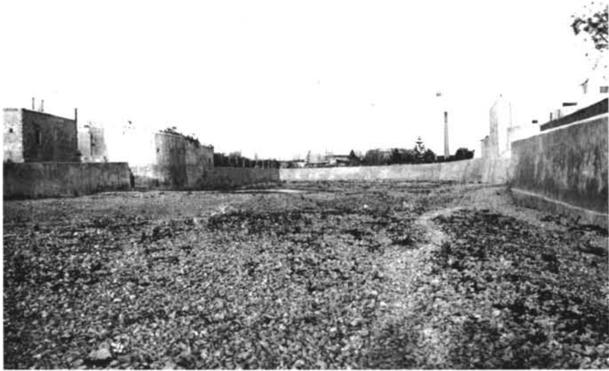
Foto 17. Largo muro curvo de la margen izquierda de la rambla de Amatisteros para defender al Barrio Alto (Memoria "Consuegra-Almería". 1905. Archivo Municipal de Almería)
