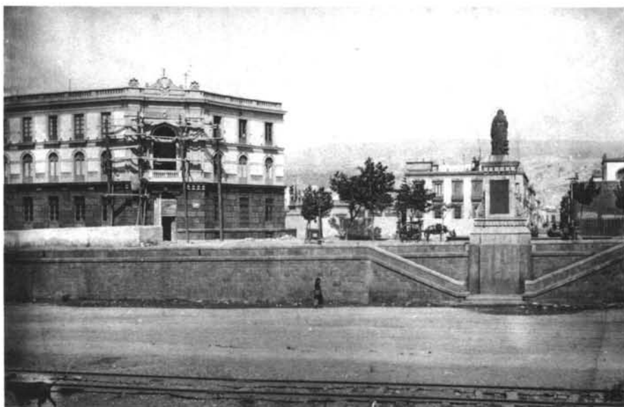
Foto 16. Escalinata de acceso a la rambla y monumento conmemorativo en la plaza Circular.
