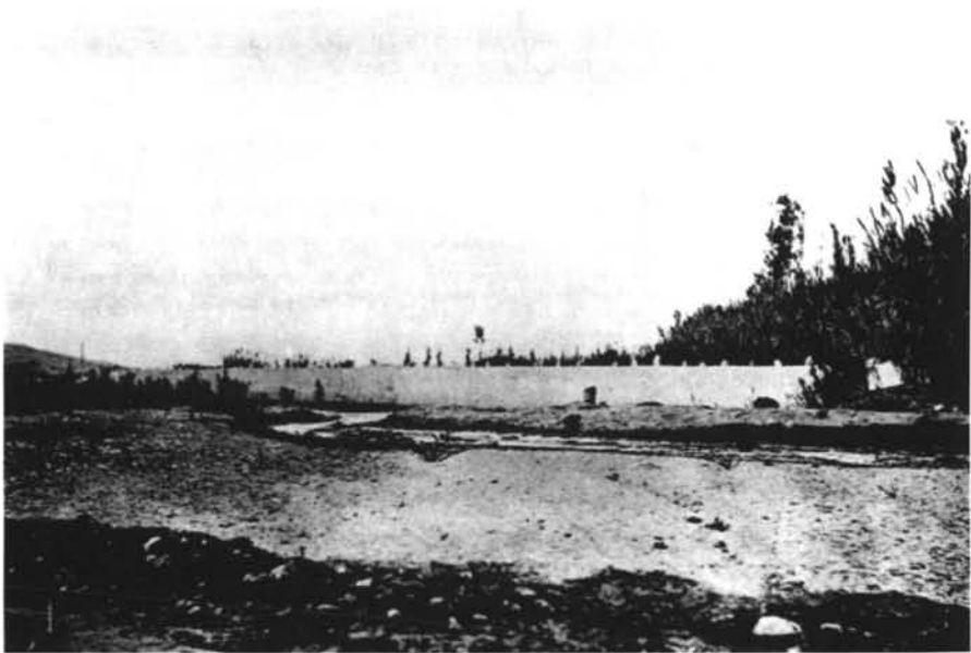
Foto 18. Muro de defensa de la taza de la fuente. Se aprecia el curso del río en primer plano forzando a desviar la corriente de su itinerario. (Memoria "Consuegra-Almería". 1894. Biblioteca Nacional)
