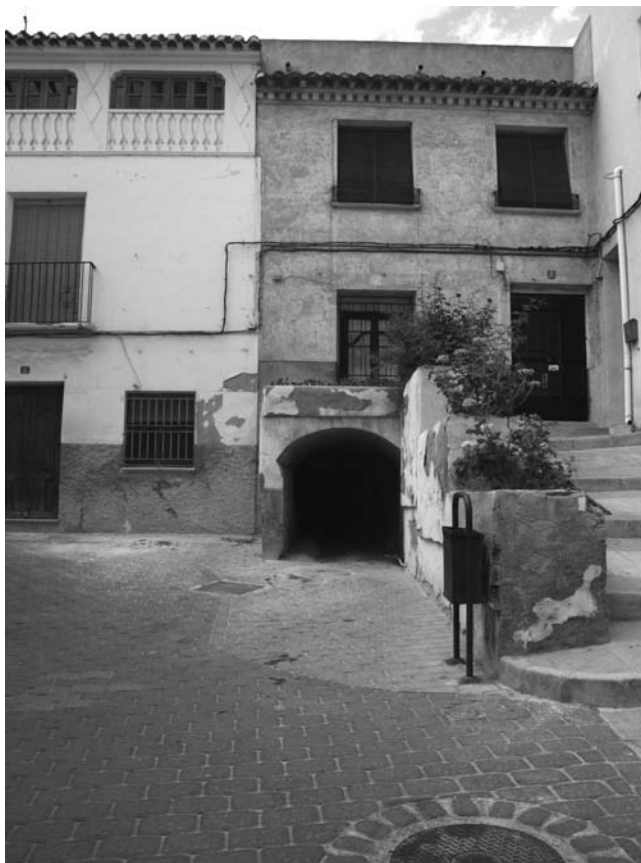
Foto 6. Salida del túnel-galería, que recoge las aguas del barranco de “El Cabezo”, en la plaza de “Esquina Palacio”.
