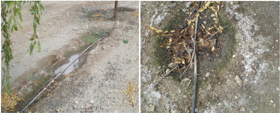
Imagen 4.3. Sistema de riego
