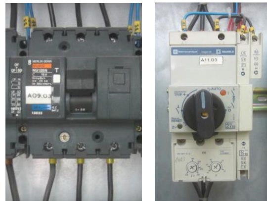
Figura 4. Izquierda. Interruptor automático de la gama NG125 perteneciente a la marca Merlin Gerin ®. Derecha. Dispositivo de protección y accionamiento para motores perteneciente a la gama integral de la marca Telemecanique ®.
