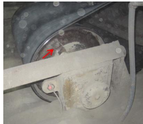
Figura 17. Detalle de la instalación de un controlador de giro en el tambor de cola de una banda transportadora.
