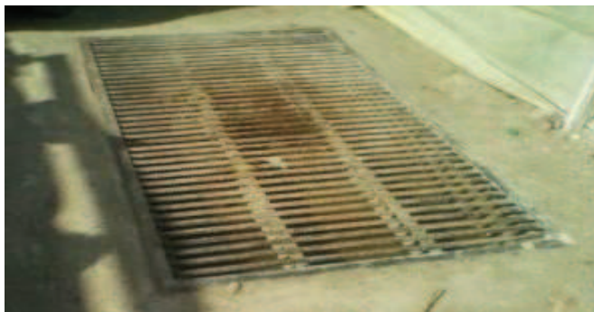
Figura 24. Depósito de sobrantes.
