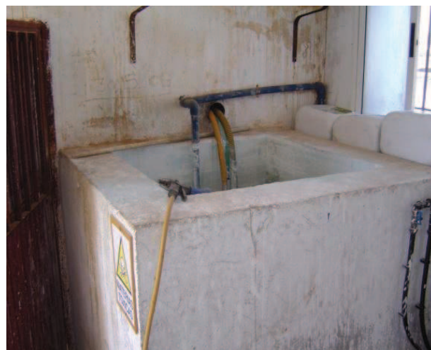
Figura 39. Deposito de obra
