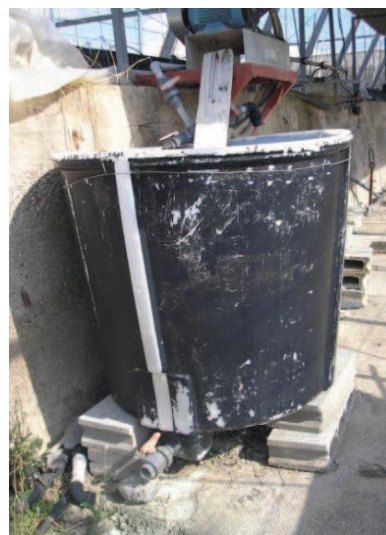
Figura 46. Depósito sin tapadera
