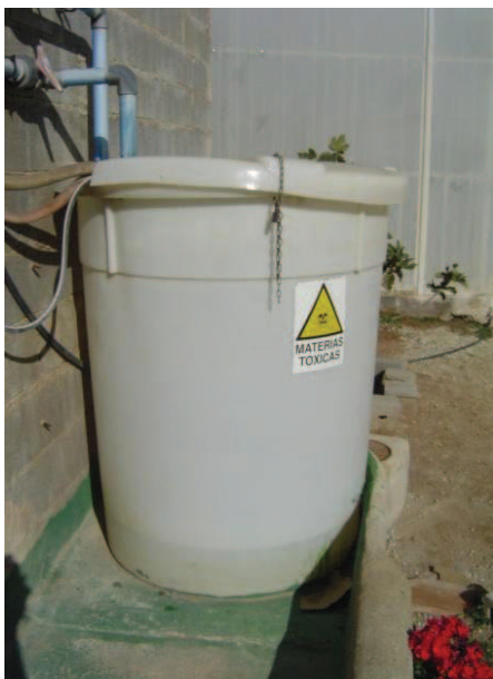
Figura 33. Depósito con resguardo
