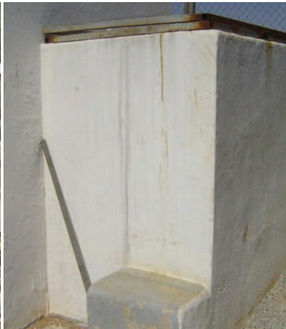
Figura 50. Depósito sin dispositivo de vaciado
