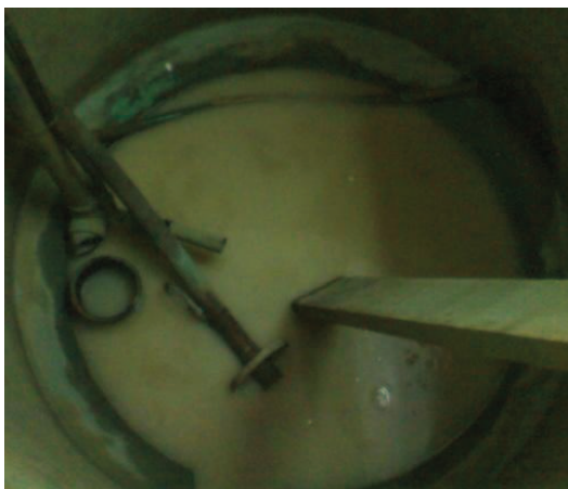
Figura 99. Filtro en mal estado
