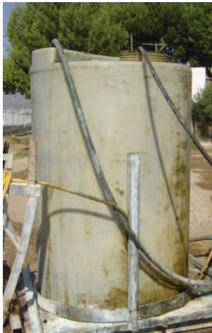
Figura 50. Depósito sin dispositivo de vaciado
