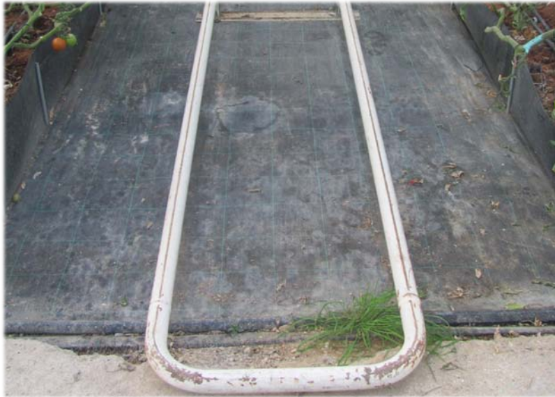
Figura 7. Calefacción por tuberías con agua caliente.
