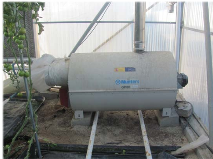
Figura 5. Generador de aire caliente de combustión indirecta.
