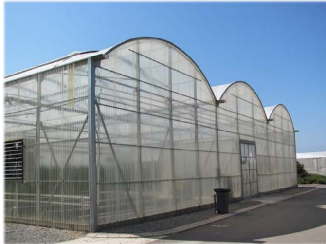
Figura 15. Detalle general de la estructura del invernadero U9.
