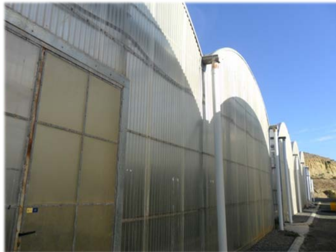
Figura 25. Detalles de las canaletas de desagüe.
