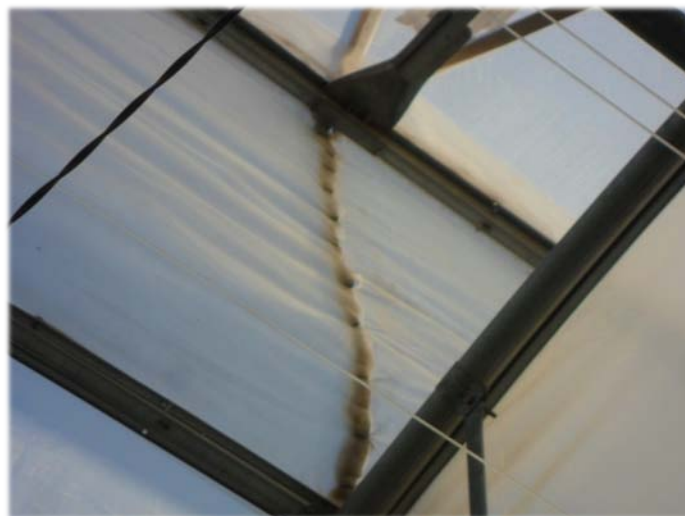
Figura 32. Detalle de la unión de las mallas de los sectores Este y Oeste en invernadero multitúnel.
