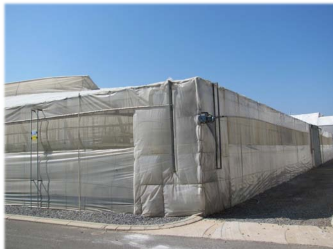
Figura 16. Detalle general de la estructura del invernadero U8.
