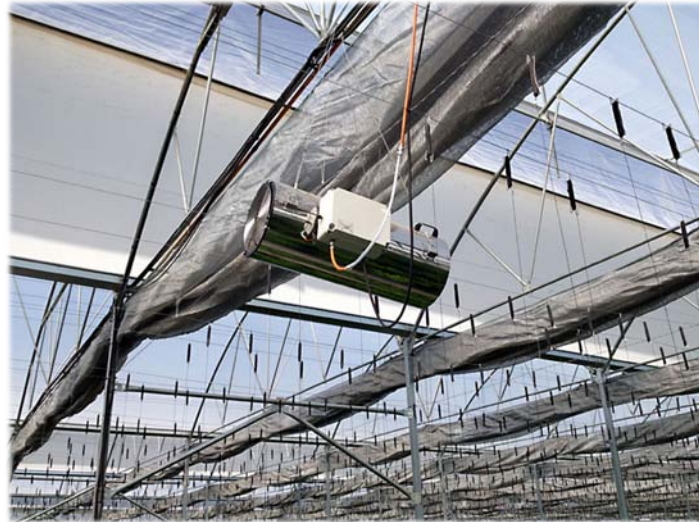
Figura 4. Generador de aire caliente de combustión directa.
