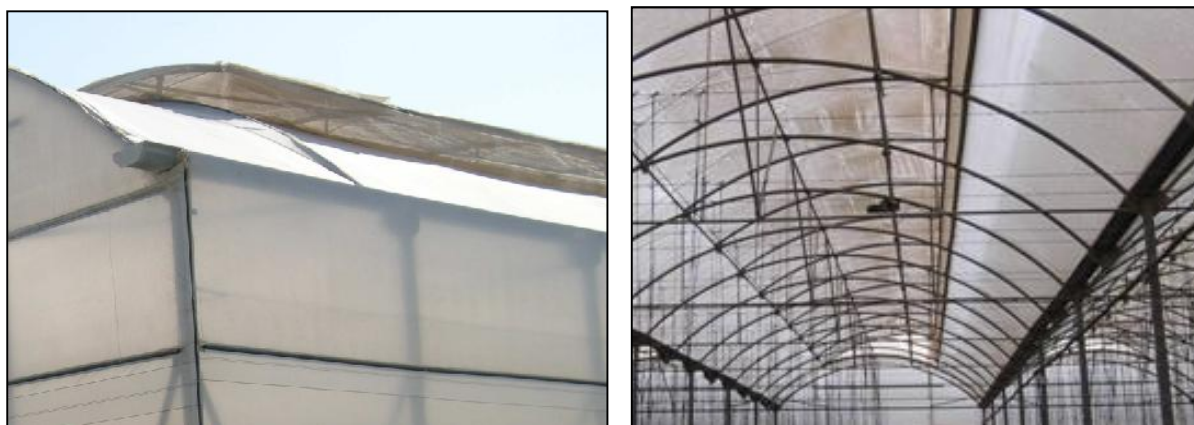
Figura 75. Vista exterior (izquierda) e interior (derecha) de las ventanas cenitales.
