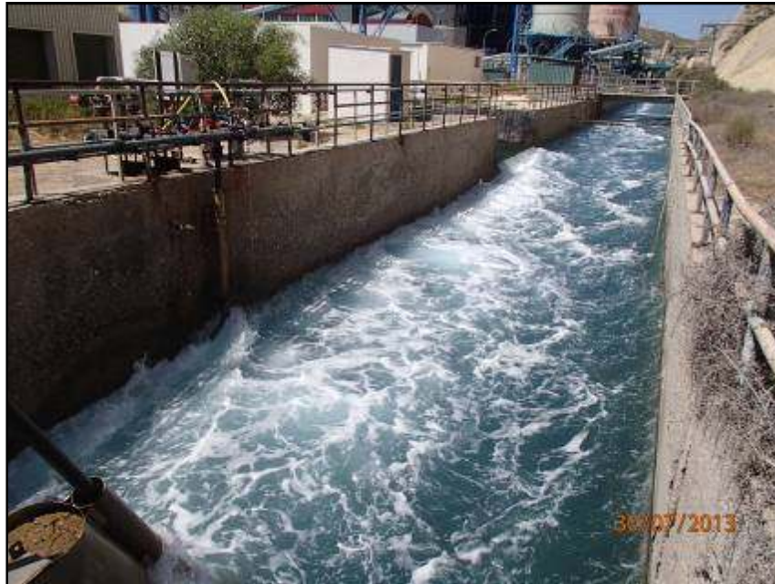
Figura 2.23.- Canal de descarga de la CTLA ( Elaboración Propia )
