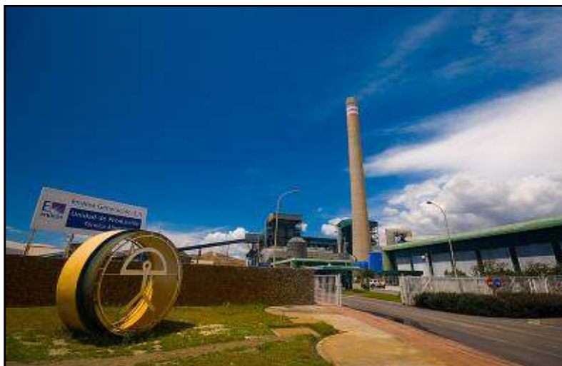
Figura 3.2.- Entrada a la CTLA (Elaboración propia)
