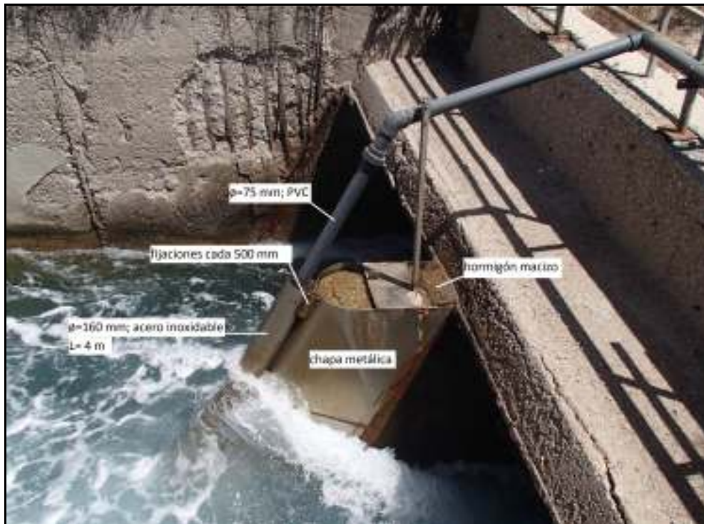
Figura 5.9.- Toma del agua residual al final del canal de descarga (Elaboración Propia)
