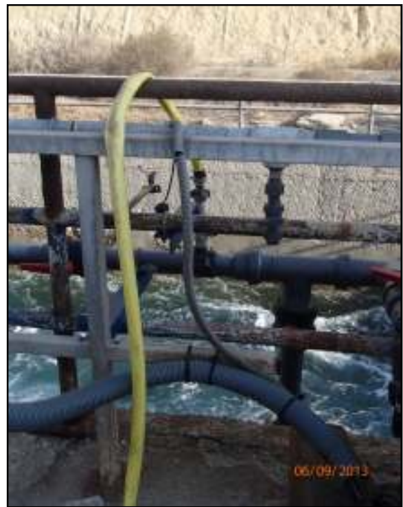
Figura 5.6.- Colocación de la manguera ( Elab. Propia )
