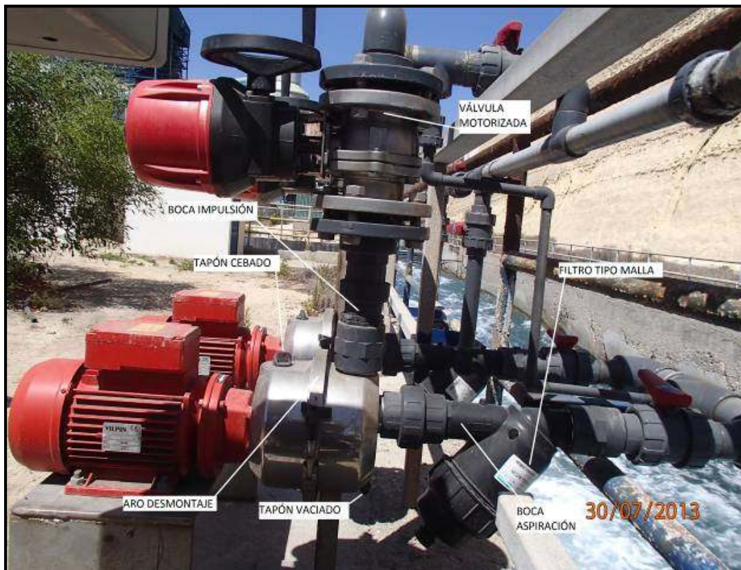
Figura 5.14.- Sistema de válvulas ( Elaboración Propia )
