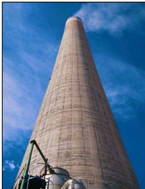
Figura 2.14.- Chimenea industrial de unos 200 metros de altura (CRINA, 2008)
