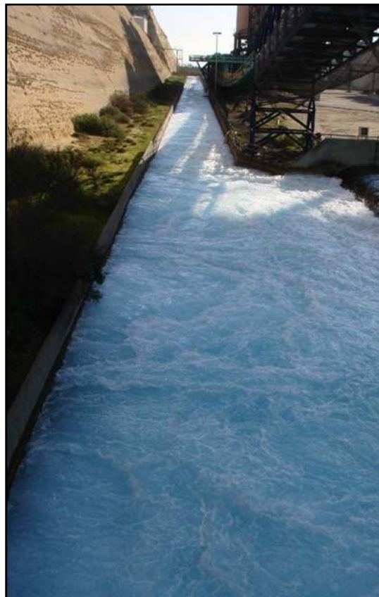
Figura 3.13.- Canal de descarga visto desde la cámara de rotura (Elaboración propia)
