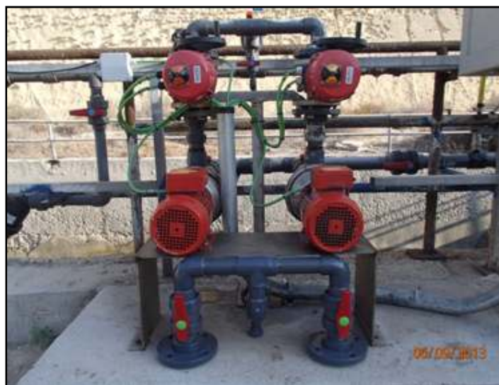
Figura 5.2.- Disposición de las nuevas bombas ( Elaboración Propia )
