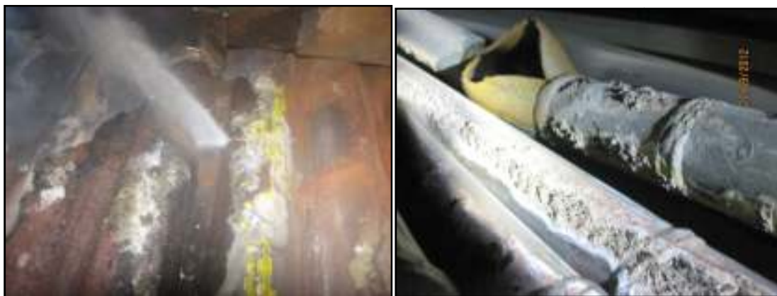
Figura 2.10.- Ejemplos de “pinchazo” de un tubo (Elaboración propia)
