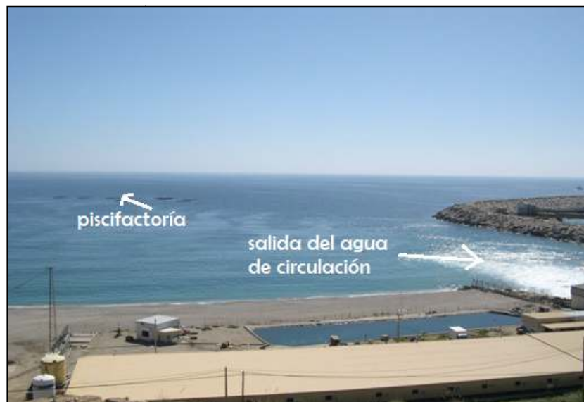
Figura 3.14.- Vista panorámica de la evacuación del agua de refrigeración ( Elaboración propia )
