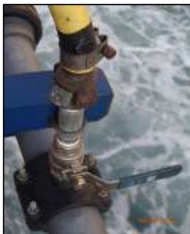
Figura 5.7.- Detalle de conexión de manguera-tubería (Elaboración Propia)
