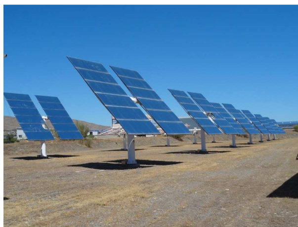
Figura 6.12. Helióstatos de la línea 8 de comunicaciones en posición de seguimiento desfasado
