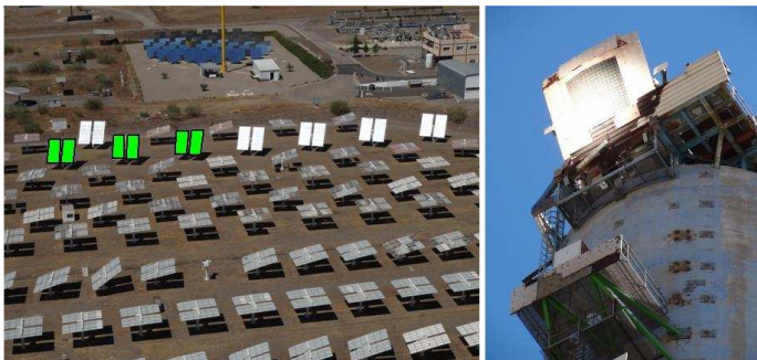
Figura 6.18. Estado del sistema en el instante t1, los helióstatos 143, 144 y 145 son enfocados
