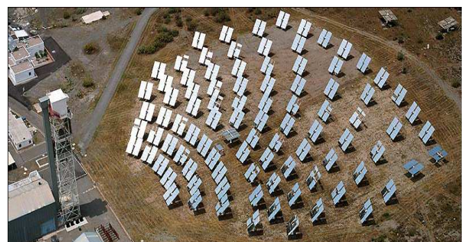
Figura 1.3. Vista aérea de la instalación SSPS-CRS con los helióstatos enfocando al nivel superior de ensayos (43 m.)
