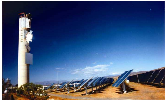
Figura 1.2. Vista lateral de la instalación CESA-I con los helióstatos enfocando al nivel intermedio de ensayos (60 m.)
