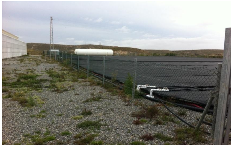
Figura 49. Vista de la cubierta de las balsas de riego
