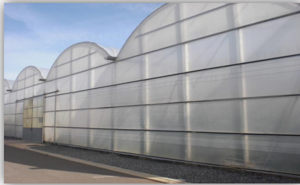
Figura 50. Exterior del invernadero.
