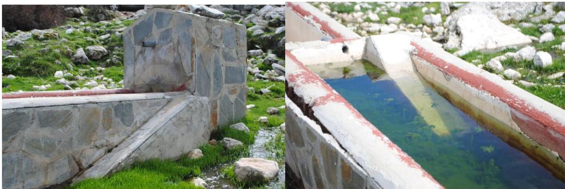
Imagen 42: Construcción de rampas de acceso y salida para anfibios. Fuente: Elaboración propia.
