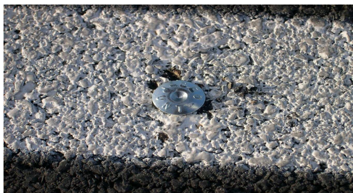
Foto 3: Punto de estacionamiento de la base.
