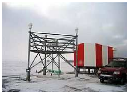
Figura 4. Estación de Referencia WAAS en Barrow, Alaska.
